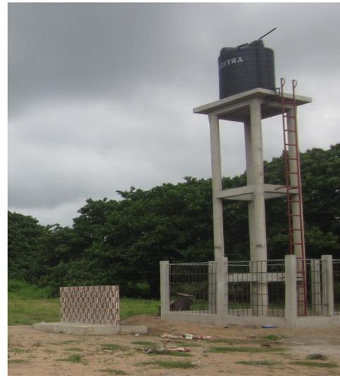
Le château d'eau était clôturé et à côté, le point d'eau avec des robinet a été installé et joliment carrelé.
