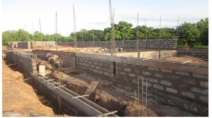
Les bâtiments sont situés sur une pente. Il fallait donc faire un chaînage additionnel dans la fondation. Après le chaînage de bas a été coulé. Les murs y poussaient. Le petit chaînage a été coulé sous les ouvertures des fenêtres.
