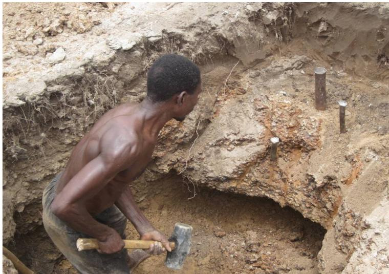
La fréquence des pluies n'a pas permis que les travaux des toilettes continuent car Sokponta étant situé au pied des montagnes, ne possède pas un sol assez perméable. Ceci fait que l'eau des pluies s'accumule dans la fosse.
