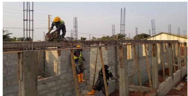
Darauf werden die Mauern um 4 Bausteinreihen erhöht, ehe der vierte Eisenanker unterhalb des Daches gegossen wird.
