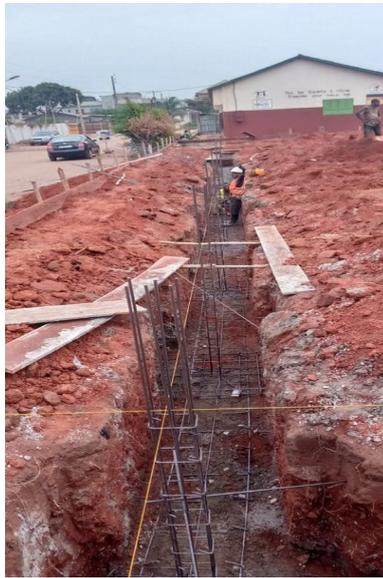
Darüber wird die zweite bewehrte Betonschicht gegossen. So bald sie getrocknet ist, entstehen darauf die Fundamentmauern.
