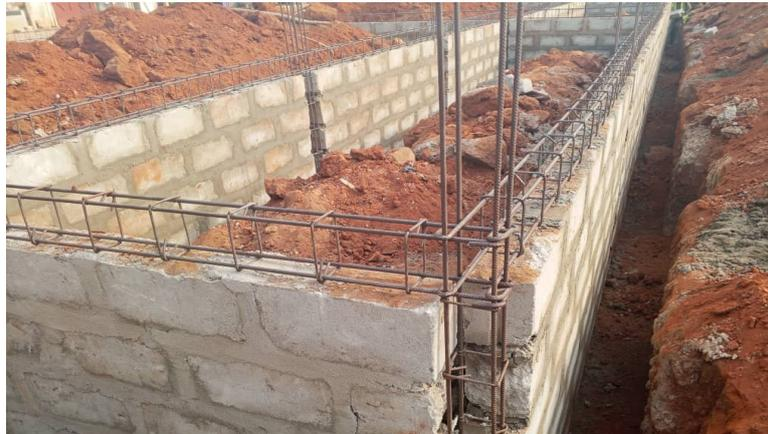
Auf dem Eisenringanker werden die Mauern des Gebäudes errichtet. Als die Wände die Höhe der Fensteröffnungen erreichen, wird ein kleiner Eisenanker eingezogen.
