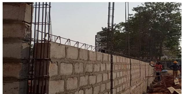
Dann wachsen die Wände schnell bis zum Fenstersturz an. Nachdem die Pfeiler an der Veranda gegossen wurden, wird der obere Eisenanker aufgelegt, verschalt und in einem Stück gegossen.
