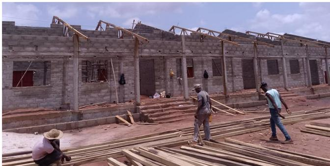
Darüber werden die Längsbalken angebracht und die asbestfreien Eternitplatten angeschraubt.
