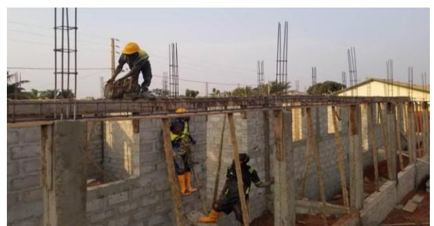
屋根の下にくる4つ目の鉄筋アンカーを打設する前に、壁をさらにブロック4段分高く積み上げます。
