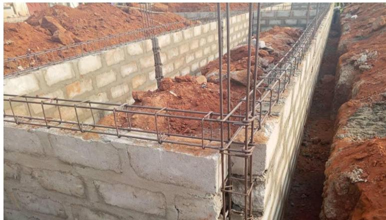
この鉄筋コンクリートの梁の上に、建物の壁を積み上げていきます。壁が窓の開口部の高さに達したところで、小さな鉄筋アンカーを設置します。
