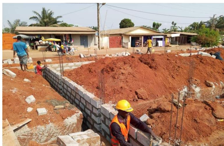
1月26日には、早くも下部の鉄筋アンカーの設置、型枠組み、コンクリート打設が行われました。
