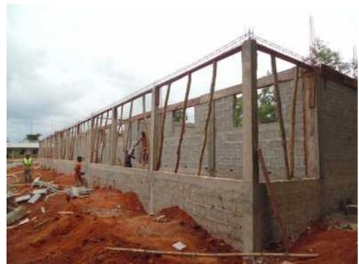
An beiden Gebäuden wird die Verschalung für die oberen Eisenanker vorbereitet, die als ein Stück gegossen werden müssen.
