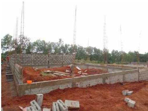
Über den Fundamentmauern wurde der untere Eisenanker gegossen.
