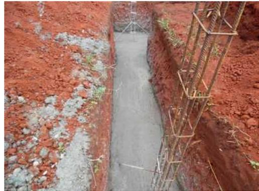
Darüber wird die Bodenunterlage gegossen
