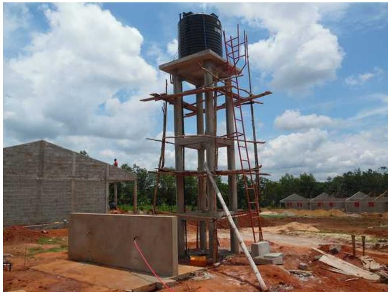
Der Wasserturm ist fertig, die Pumpe eingesetzt, der Tank angeschlossen und die Leiter, die auf den Turm führt, eingebaut.
