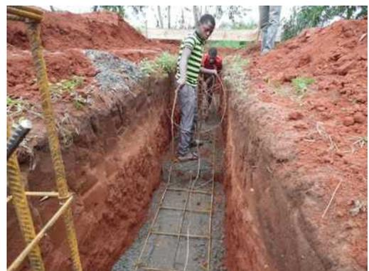
Die Erdung des Blitzableiters wird von den Elektrikern angebracht.
