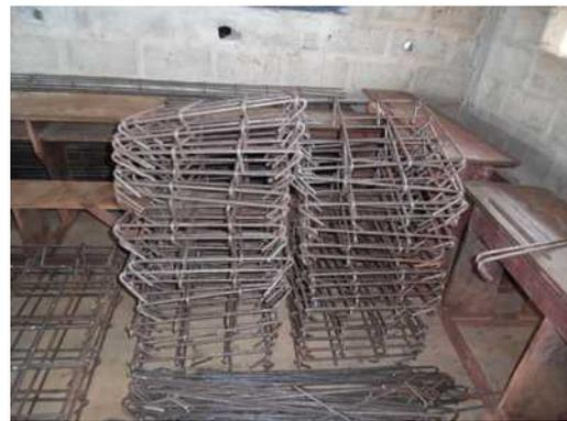
Die Eisenunterlagen für die Fundamentmauern und die Pfeiler werden gefertigt.
