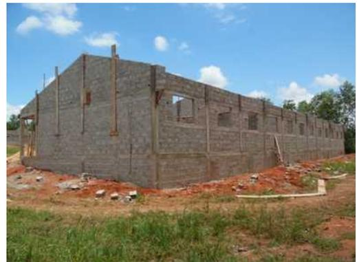
Die oberen Eisenanker wurden gegossen und die Giebel aufgemauert.
