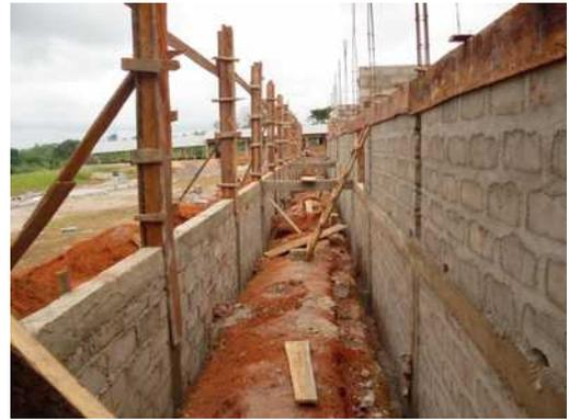
Die Verschalungen für die Pfeiler der Veranda werden angebracht und der kleine Eisenanker unterhalb der Fensteröffnungen wird gegossen.
