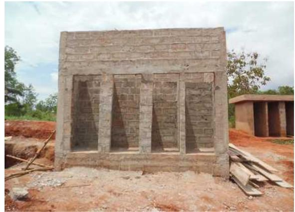
Die Toilettengruben wurden ausgemauert, geschlossen und die Häuschen darüber errichtet
