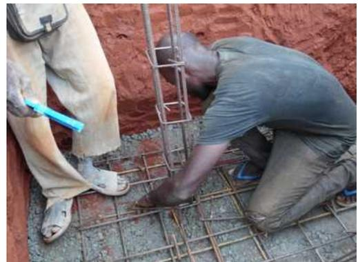
und die Eisenunterlage für die Mauern und die Pfeiler platziert.
