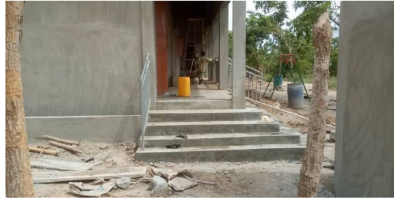
Le faîtage du toit est fermé.
